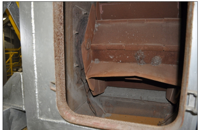
搬送コンベヤ：針金等が引っかかりやすい
