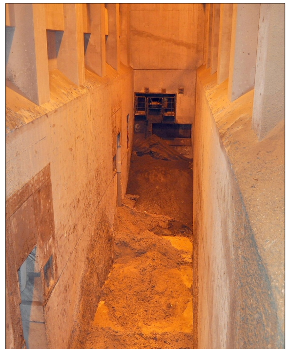
江戸川工場の灰バンカー。手前の主灰に比べ奥の飛灰の貯留状況は限界に近づいている
