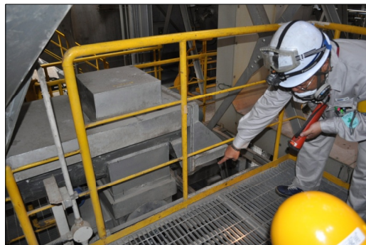
写真上：飛灰貯留槽 写真下：焼却飛灰の処理の流れを説明いただく
