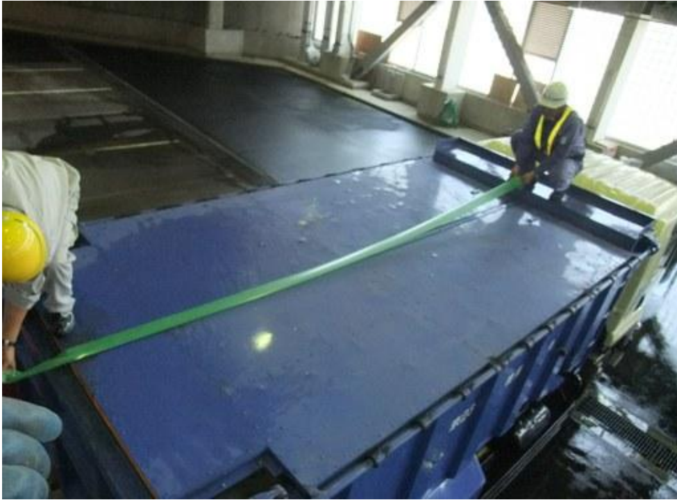
天蓋を閉め目張りする(1)
