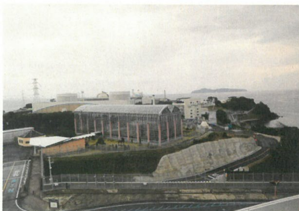
▲玄海原発、4機のうち1号機は廃炉となる
