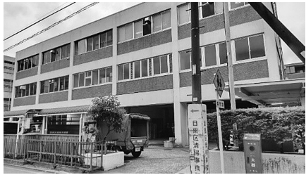
▲老朽化が進む清掃事務所は建替必須だ
