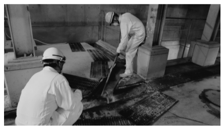
▲施設内排水整備
