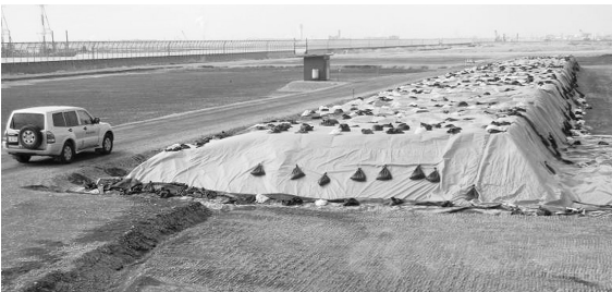
最終処分場で保管されている飛灰処理汚泥
